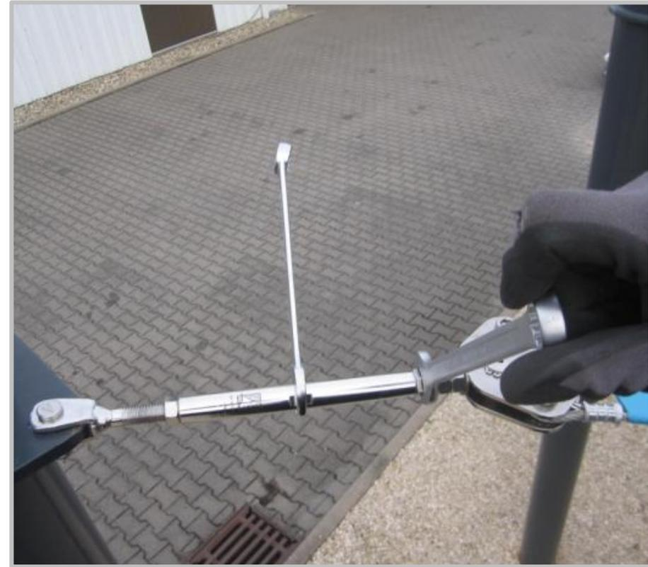
Entfernen Sie den Kettenzug nach dem Einhängen des Wantenspanners. Drehen Sie die Wantenspanner (je nach Segelgeometrie) gleichmäßig an den diagonal gegenüberliegenden Aufhängepunkten zu, um ungleichmäßiges Spannen zu verhindern.
