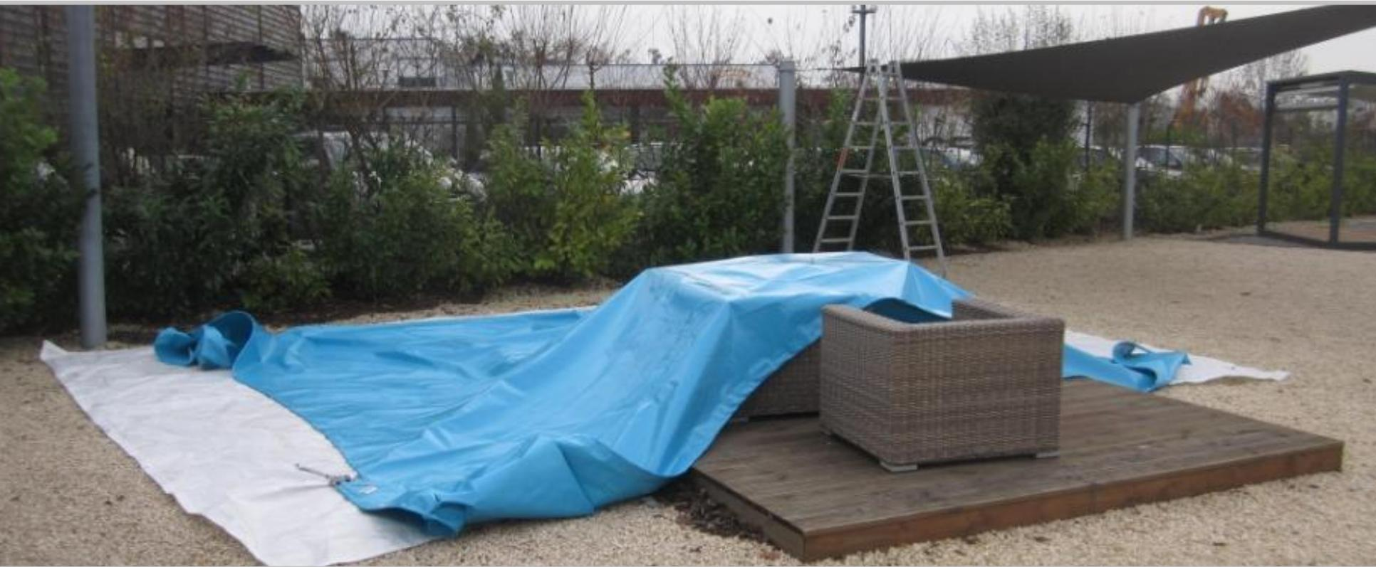
Breiten Sie das Sonnensegel aus. Die Ausrichtung muss so erfolgen, dass Mast- und Eckbeschlag P1 zueinanderpassen. Der Punkt P1 wird anhand des Aufmaßes oder Zeichnungen bestimmt.
