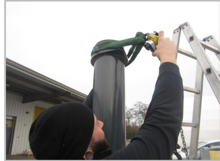
Hängen Sie den Kettenzug mittels Rundschlinge am Mastkopf und an den vorbereiteten Schlaufen am Eckbeschlag ein und ziehen Sie den Eckbeschlag zum Mastbeschlag.
