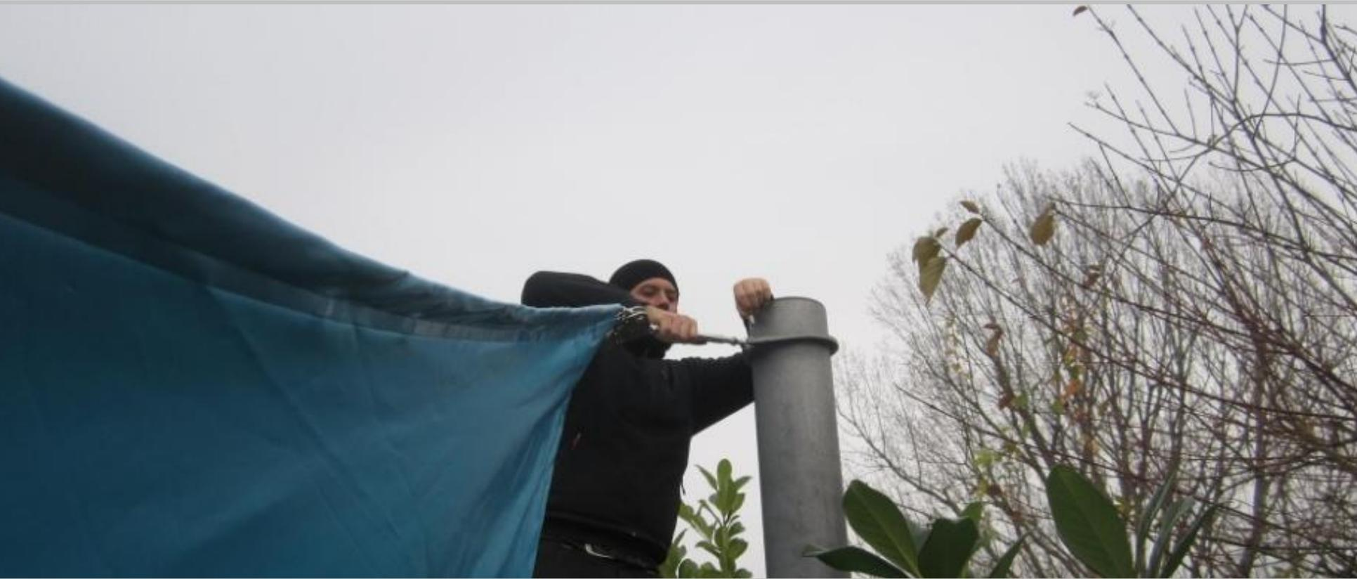
Drehen Sie die Wantenspanner an allen Segelecken auf. Die Gewindestangen der Gabelköpfe sollten zu 1/3 in der Spannhülse eingedreht bleiben.
