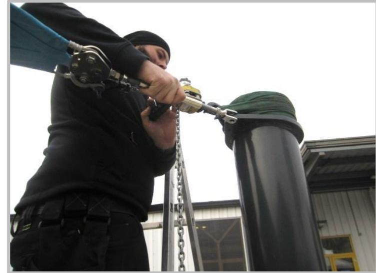
Ziehen Sie den Gabelkopf über den Mastbeschlag. Schieben Sie den Bolzen ein und montieren Sie die Sicherungsplatte.
